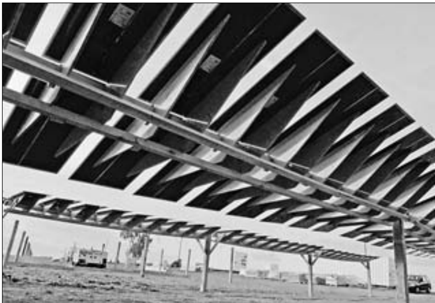
Blick auf eine sich in Deutschland in Bau befindliche Solaranlage.
